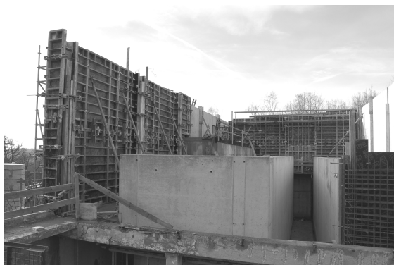
Obr. 4, 5. Betonáž haly a nádrží flotace
